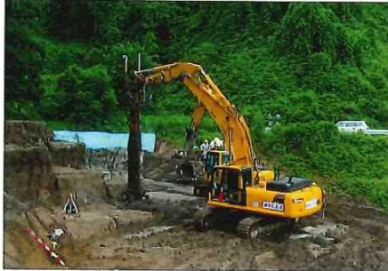
トンネル出口坑口部における改良施工
