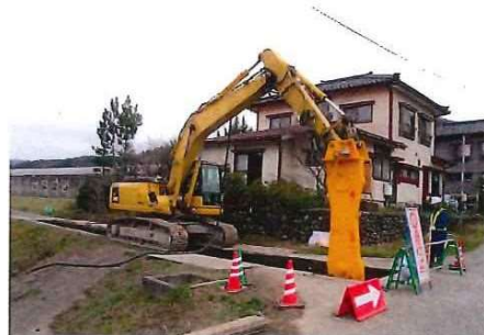
民家の近接部における改良施工
