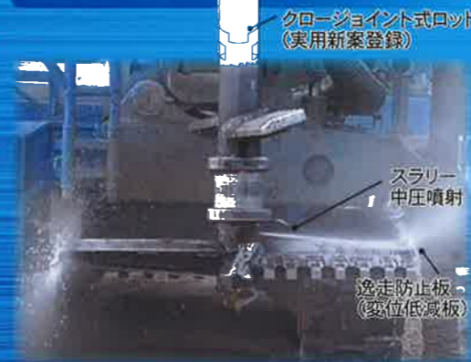
CMS-S中圧噴射システム用攪拌翼 中圧噴射状況 (P=～19.6MPa)
