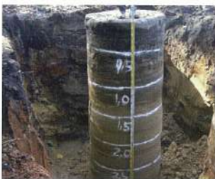
● 掘り出し調査
