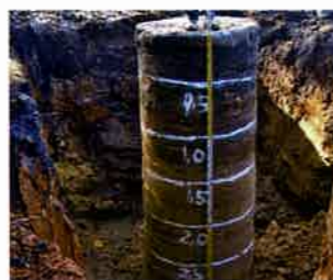
●掘り出し調査
