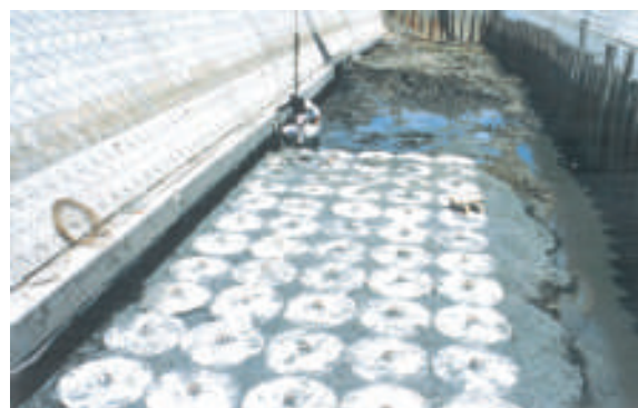
河床の浸食・洗掘防止用基礎
