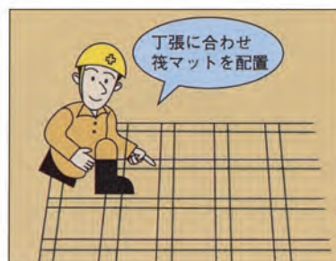
2. 筏マットの敷設
