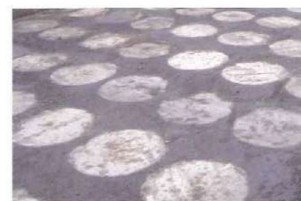
杭頭部確認状況
