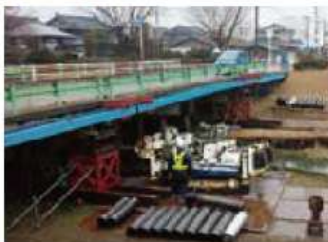
SSSタイプ 走行時750mmの超狭径対応マシン
