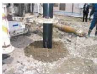
無排土施工状況
