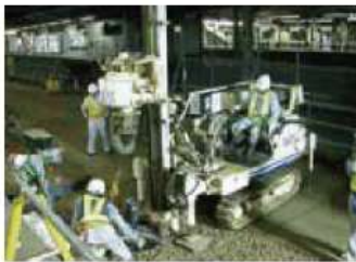
新SSタイプ 機械幅1550mm、トルク性能80kN・m
