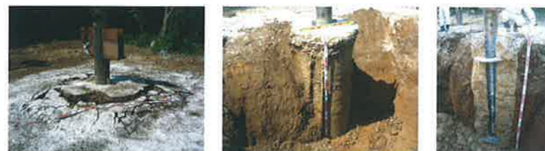
▲上記Lcには、基礎下端から2.5mの区間及び先端の先端羽根ストローク部分は含まれません。 ▲地盤条件・設計条件・施工条件等により、採用できる平均N値に制約があります。 設計支持力算定の際は、弊社まで必ずお問い合わせ下さい。
